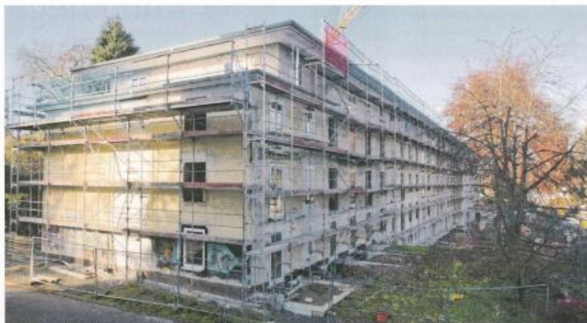
Noch wird gebaut, aber schon im Sommer soll das Haus der Begegnung in Bonn eröffnet werden. Zahlreiche Interessenten stehen schon auf der Warteliste.
